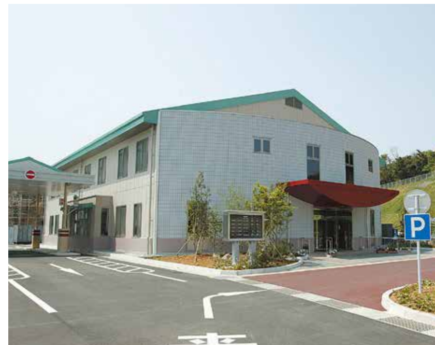
プラザ管理棟
